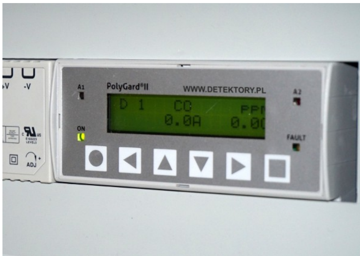
(fot.5 Na zdjęciu centrala cyfrowa PolyGard2 z podglądem detektora. Ważną funkcją w tej centrali jest możliwość podglądu wartości bieżącej (C) – po prawej, oraz wartości średniej (A) – po lewej. Funkcja konieczna przy pomiarze gazów toksycznych gdzie istotna jest średnia z danego okresu czasu lub przy eliminowaniu krótkotrwałych przekroczeń poziomu mogących niepotrzebnie wywoływać sytuację alarmową)
