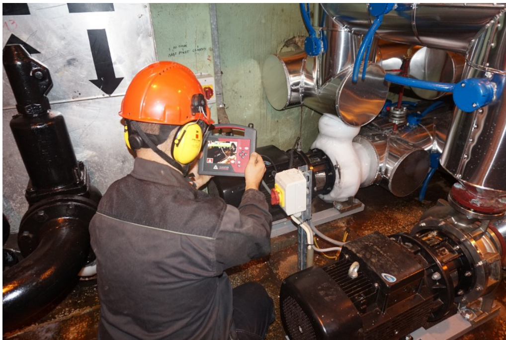
(fot.15 Diagnostyka wibracji układu za pomocą automatycznego analizatora wibracji VSHOOTER)
