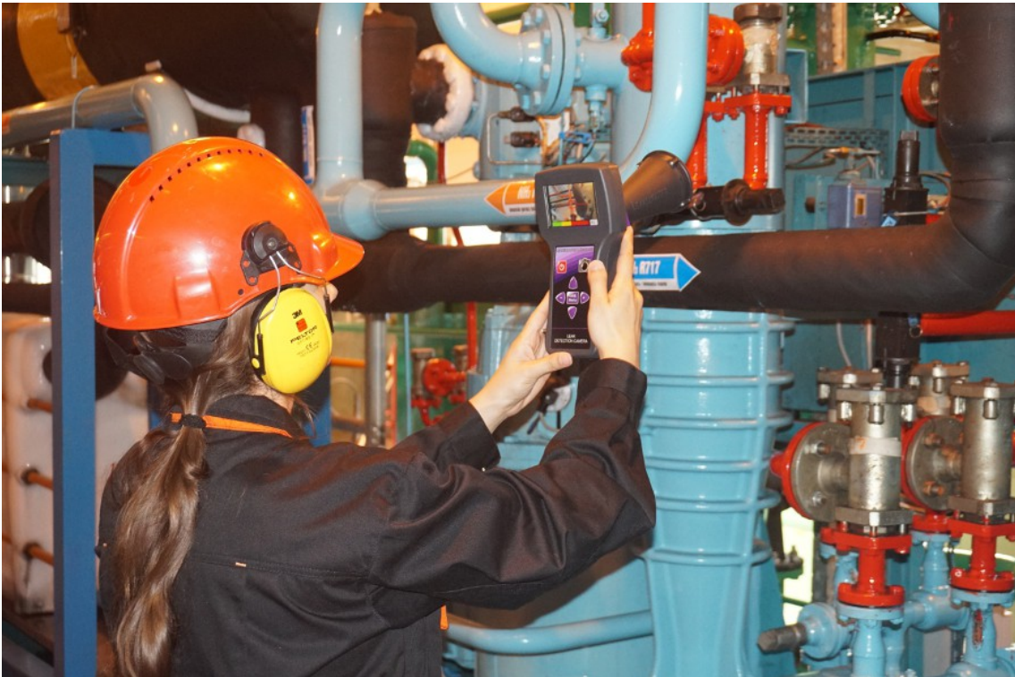
(fot.13 Badanie wycieków na instalacjach gazów sprężonych przy pomocy ultradźwiękowego wykrywacza nieszczelności z kamerą LEAKSHOOTER)
