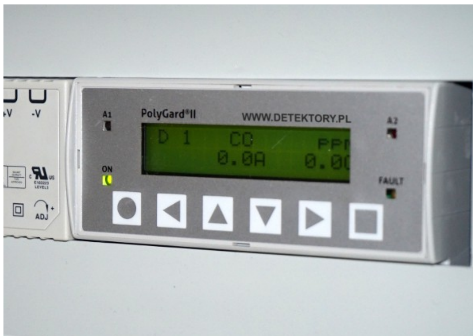
Fot.3 Na zdjęciu centrala cyfrowa MSR PolyGard2 z podglądem detektora tlenku węgla. Centrala umożliwia podgląd wartości bieżącej (C) – po prawej, oraz wartości średniej (A) – po lewej. Funkcja niezbędna przy pomiarze gazów toksycznych gdzie istotna jest średnia z danego okresu czasu lub przy eliminowaniu krótkotrwałych przekroczeń poziomu mogących niepotrzebnie wywoływać sytuację alarmową.
