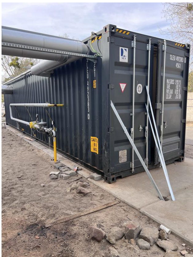
(fot.10 przykładowa kotłownia kontenerowa)
