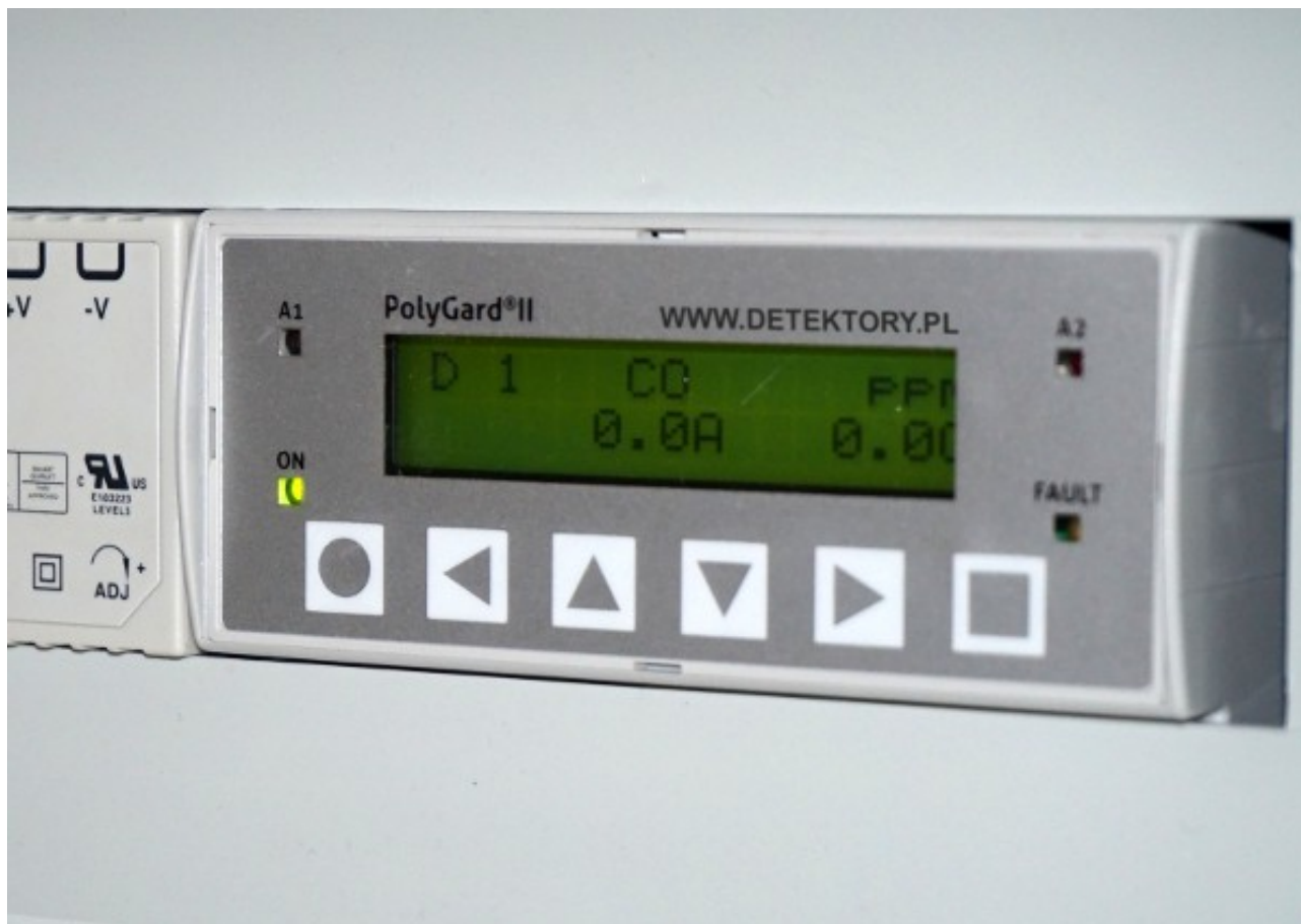
(fot.4 Na zdjęciu centrala cyfrowa PolyGard2 z podglądem detektora. Ciekawostką w tej centrali jest możliwość podglądu wartości bieżącej (C) – po prawej, oraz wartości średniej (A) – po lewej. Funkcja przydatna przy pomiarze gazów toksycznych gdzie istotna jest średnia z danego okresu czasu lub przy eliminowaniu krótkotrwałych przekroczeń poziomu mogących niepotrzebnie wywoływać sytuację alarmową)
