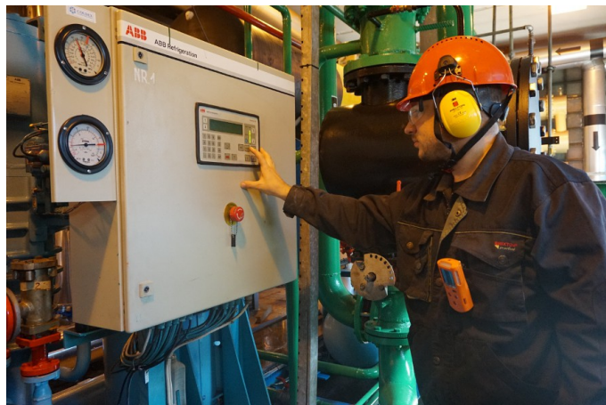
(fot.14 Pracownik używający miernika gazów MultiGasClip)
