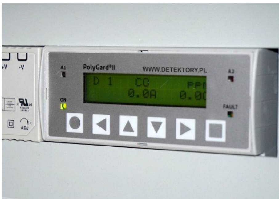
(fot.3 Na zdjęciu centrala cyfrowa PolyGard2 z podglądem detektora. Ciekawostką w tej centrali jest możliwość podglądu wartości bieżącej (C) – po prawej, oraz wartości średniej (A) – po lewej. Funkcja przydatna przy pomiarze gazów toksycznych gdzie istotna jest średnia z danego okresu czasu lub przy eliminowaniu krótkotrwałych przekroczeń poziomu mogących niepotrzebnie wywoływać sytuację alarmową)
