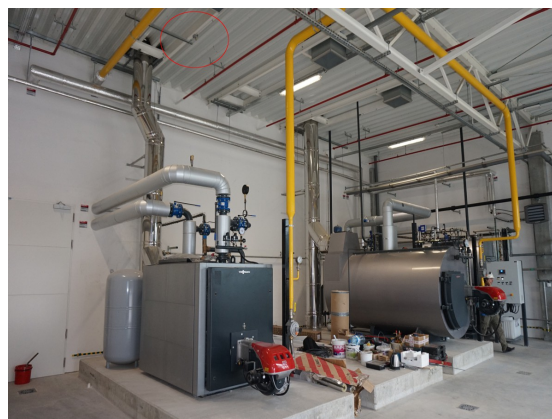
(fot.4 przykład braku dostępu serwisowego)
