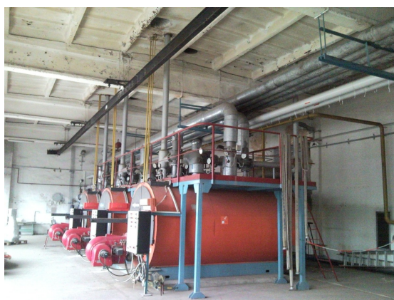
(fot.7 przykład kotłowni z istotnymi przeszkodami w postaci dźwigarów)
