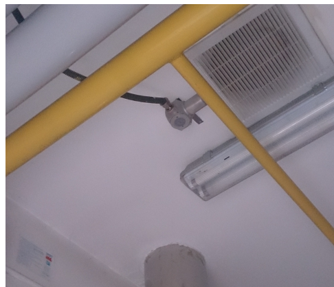
(fot.8 Detektor umieszczony zbyt blisko wlotu wentylacji na powyższym zdjęciu nie będzie prawidłowo realizował pomiaru.)
