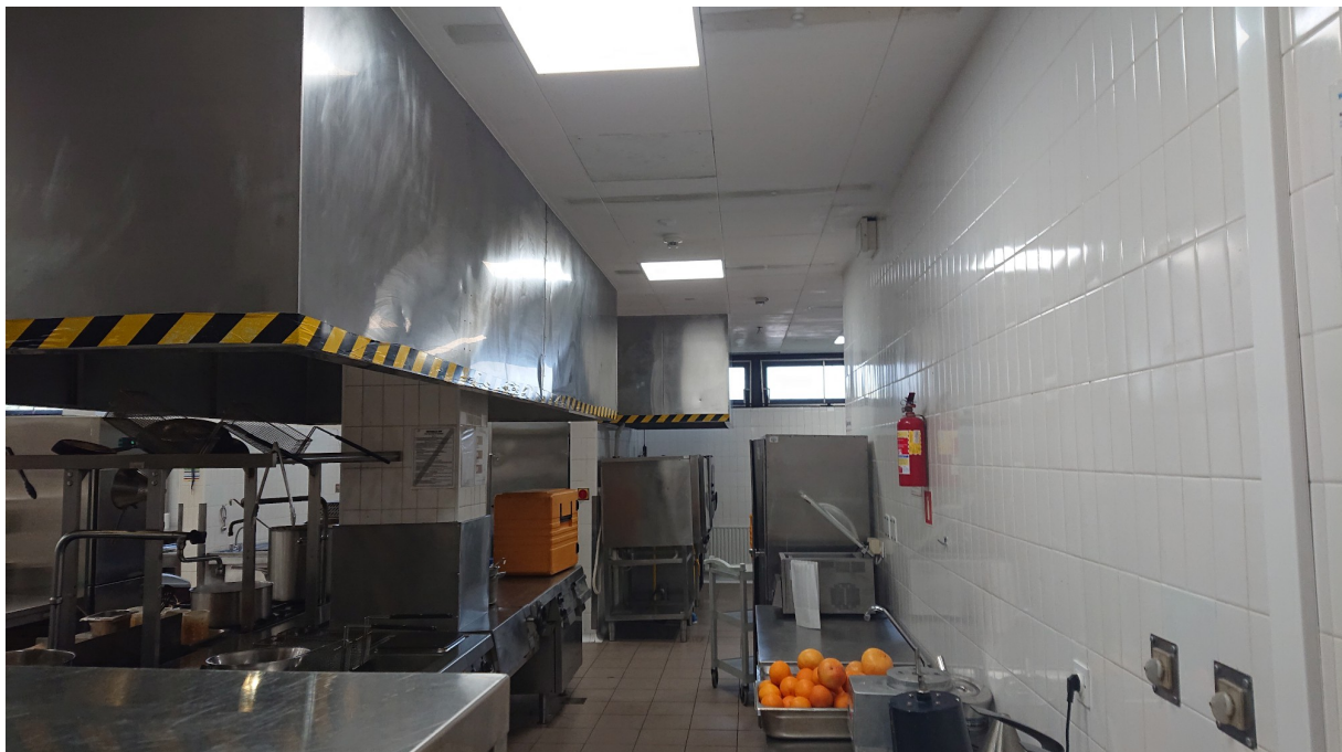
(fot.8 Inne ujęcie kuchni z sufitem podwieszanym oraz okapami. Z jednej strony pojawia się trudność oceny szczelności sufitu podwieszanego pod kątem wnikania gazu do przestrzeni między-sufitowej, a z drugiej okapy stanowią bardzo istotną przeszkodę dla dyfuzji gazu. W takich obiektach należy bardzo dokładnie przeanalizować wybór miejsc dla detektorów.)
