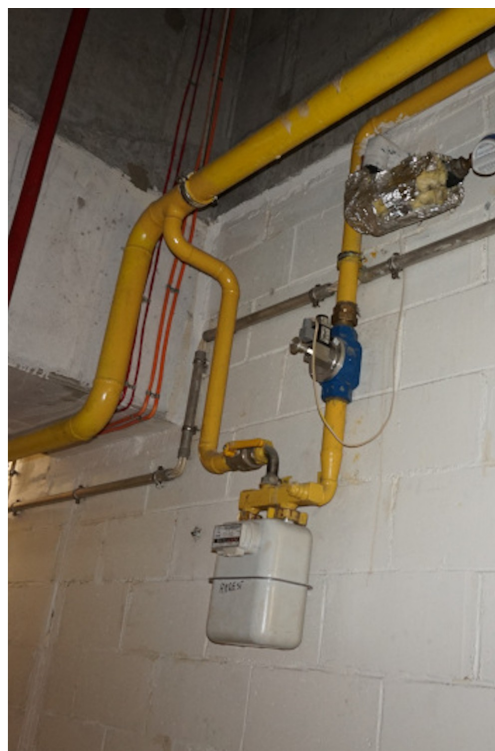
(fot.11 Przykłady zaworów elektromagnetycznych w korytarzu technicznym na rurociągach wchodzących do lokali. Wyraźnie widać, że zawór ręczny, licznik i śrubunek wejściowy zaworu elektromagnetycznego muszą być chronione detektorem w korytarzu i odcinaniem głównego rurociągu przez zawór główny na zewnątrz obiektu. Jednak dzięki temu rozwiązaniu alarm w lokalu spowoduje odcięcie gazu tylko dla danego lokalu pozwalając na dalszą pracę obiektu. Na pierwszym zdjęciu widoczny detektor typu MSR PolyGard2. Widoczne różnice w umiejscowieniu licznika przed lub za zaworem. Na drugim zdjęciu widoczny brak odstępu prowadzonej w rurce instalacji elektrycznej od gazowej.)
