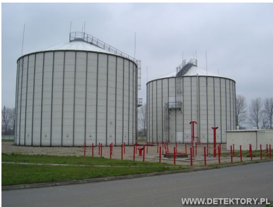
(fot.1 Zbiorniki biogazu jednej z oczyszczalni ścieków. W takim miejscu emisja biogazu może wynikiem jedynie awarii więc system detekcji powinien być odpowiednio dopasowany.)
