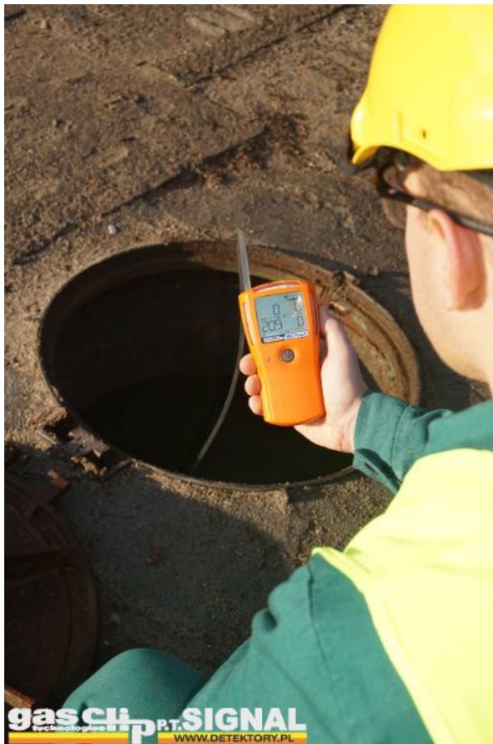
(fot.10 Pracownik używający detektora wielogazowego typu MultiGasClip PUMP przed wejściem do studzienki kanalizacyjnej)
